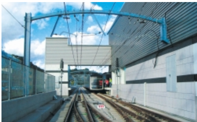
Etxebarriko geltoki berria Nueva estación de Etxebarri
