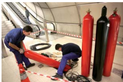
Suteak itzaltzeko sistema berria jartzen. Instalación del nuevo sistema de extinción de incendios.
