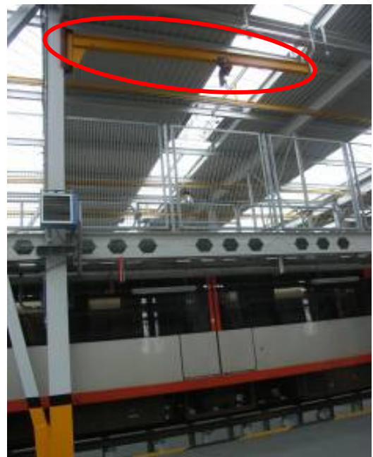
Grúa giratoria en soporte de vía 16 →
