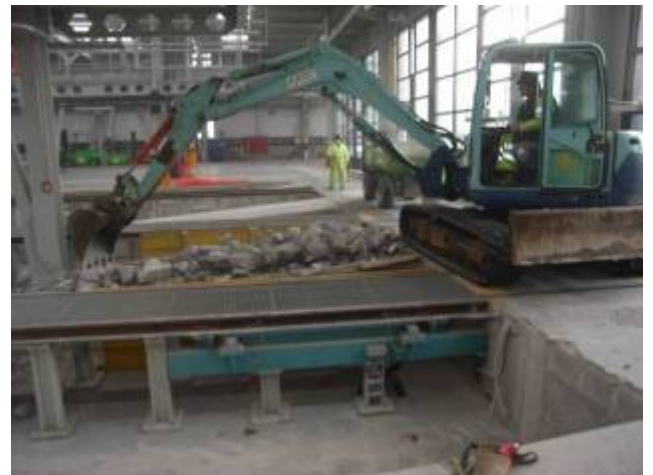
↑ Modificación en rampa de vía 14
