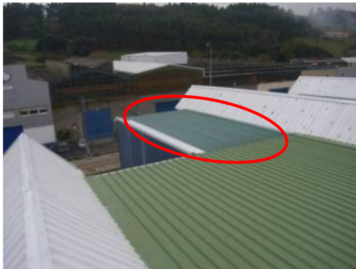
← Zona de cubierta reparada con chapa nueva
