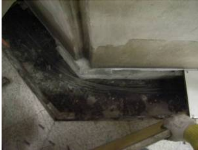
← Limpieza de canaletas y sellado de juntas
