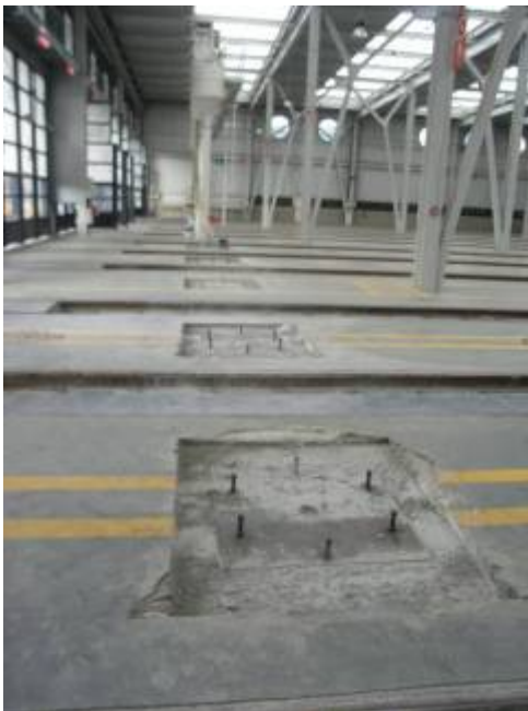
← Preparación de placas de apoyo para el traslado de silos
