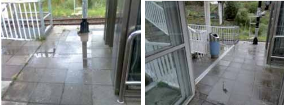
Situación antes y después de la actuación
