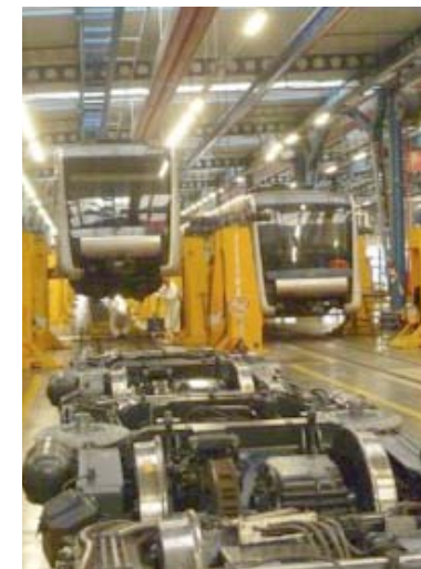
UT's en Reparación y Gran revisión P3 en líneas de levante en el área técnica de Sopela.
